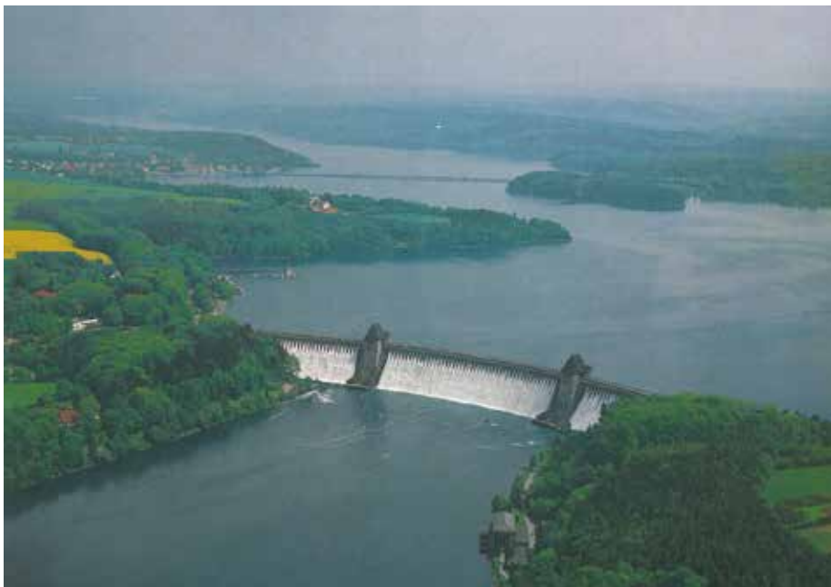
Die Sperrmauer des Möhnesees beim Überlauf im Sommer 1984.
